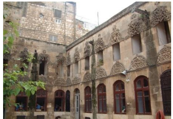
شكل رقم (٣) حالات عملية إعادة التأهيل لمباني سكنية في مدينة حلب القديمة بوظائف مختلفة
